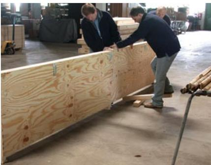
Nachdem das Lagerholz L2 aus B2 entfernt wurde, kann jetzt B2 in B1 eingehängt werden. Das Lagerholz L2 wird nun oben in B1 und B2 eingelegt, so dass es die beiden Bandenelemente verbindet und stabilisiert. Die Bezeichnung S2b auf dem Lagerholz sollte mit der Bezeichnung auf dem Beschlag übereinstimmen.
