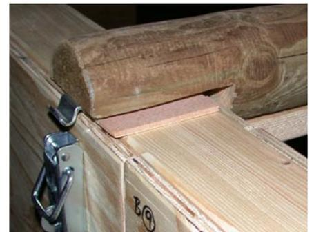
Sollte der Beschlag die Kickerstange nicht richtig fest fixieren, kann man an der Auflagefläche noch ein Stück Sperrholz unterlegen.
